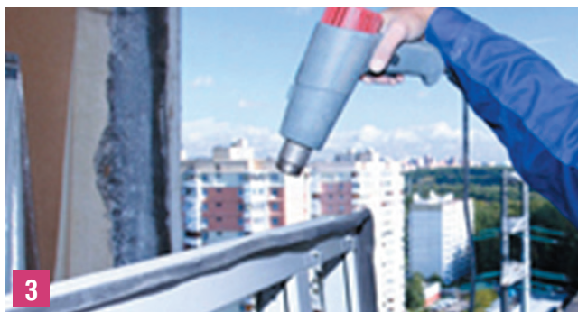
3 Установка герметизирующих лент
