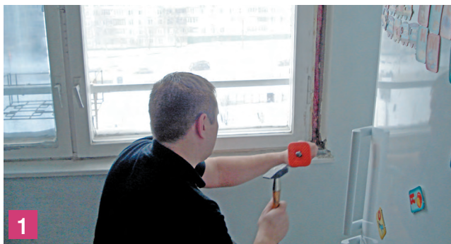
Демонтаж отливов и подоконников
