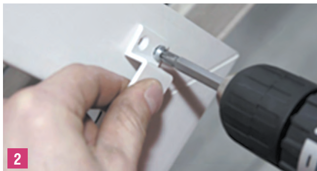
2 Сверление отверстий, установка креплений
