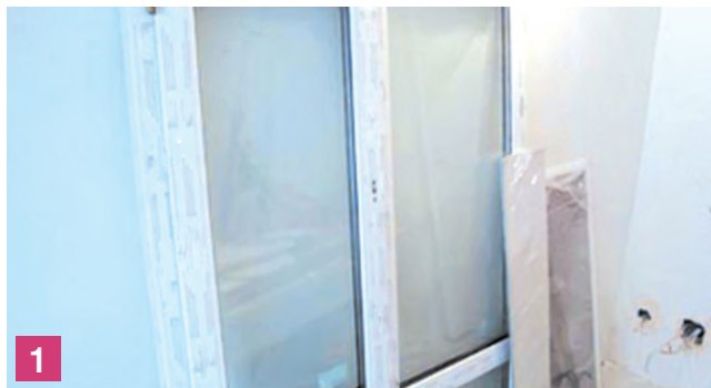
1 Расстекление глухих частей окна и снятие створок
